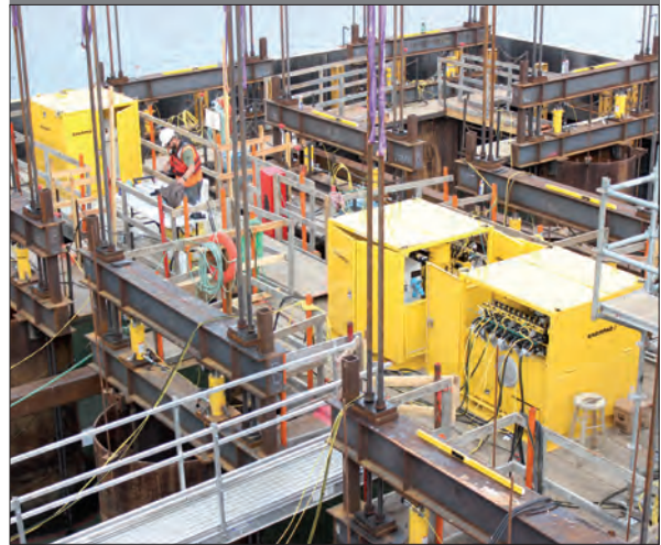
▲ Bomba hidráulica customizada para o sistema de lançamento de uma plataforma de ponte.
